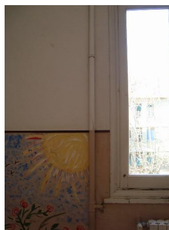
Figura 8.1 – Particolare dei serramenti esistenti
