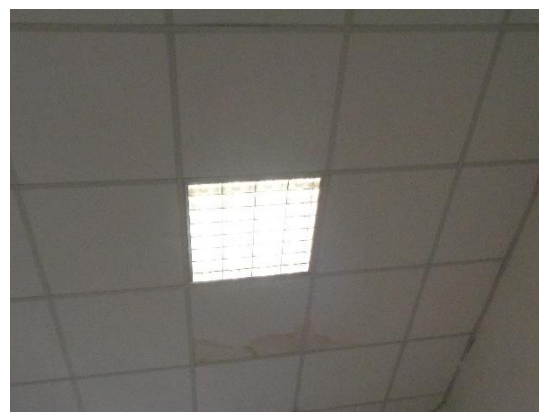
Figura 4.16 - Particolare dei corpi illuminanti ubicati nelle aule
