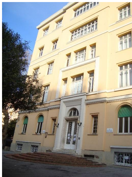
Figura 1.1 - Vista della facciata Sud
