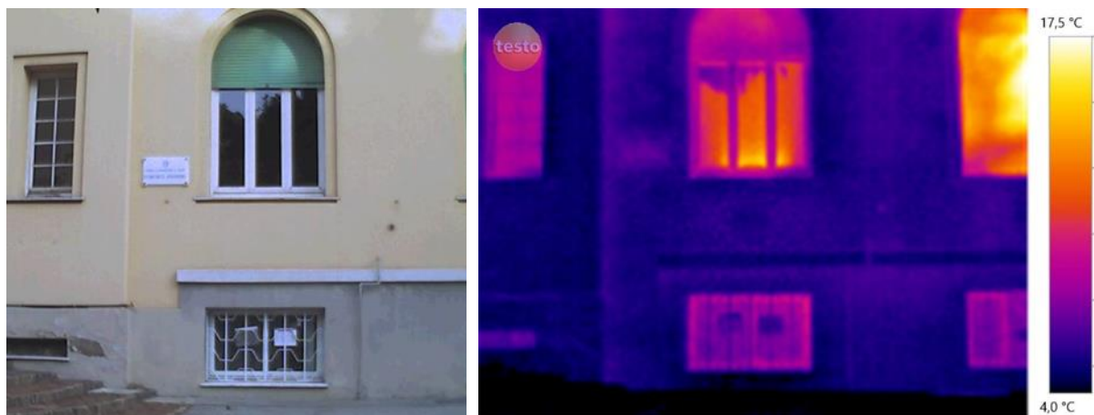
Figura 4.2 – Rilievo termografico della parete Sud
